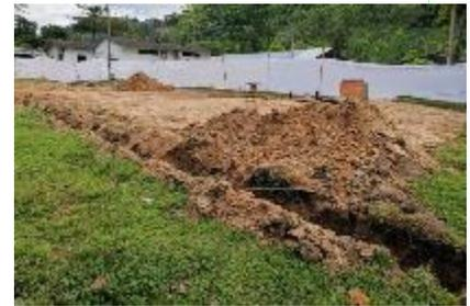
**JULIO DE 2019 -** En este mes se avanzó con las excavaciones correspondientes a la cimentación del edificio de laboratorios, se realizó el seguimiento al trazado de los ejes tanto verticales como horizontales, a su vez, se avanzó en la aplicación del concreto ciclopeo de cimentación. Se presentó un porcentaje de avance de excavaciones del 85% y del concreto ciclopeo un 40%.
