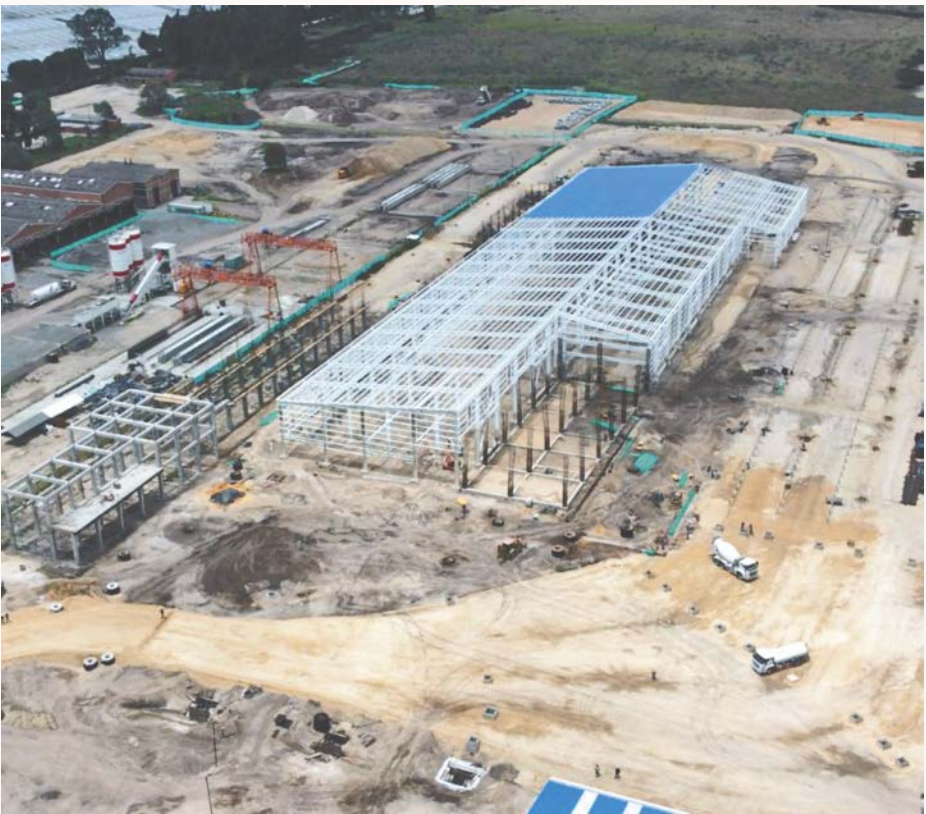
Avances en la construcción del patio taller del Regiotram de Occidente. / Empresa Férrea Regional.
