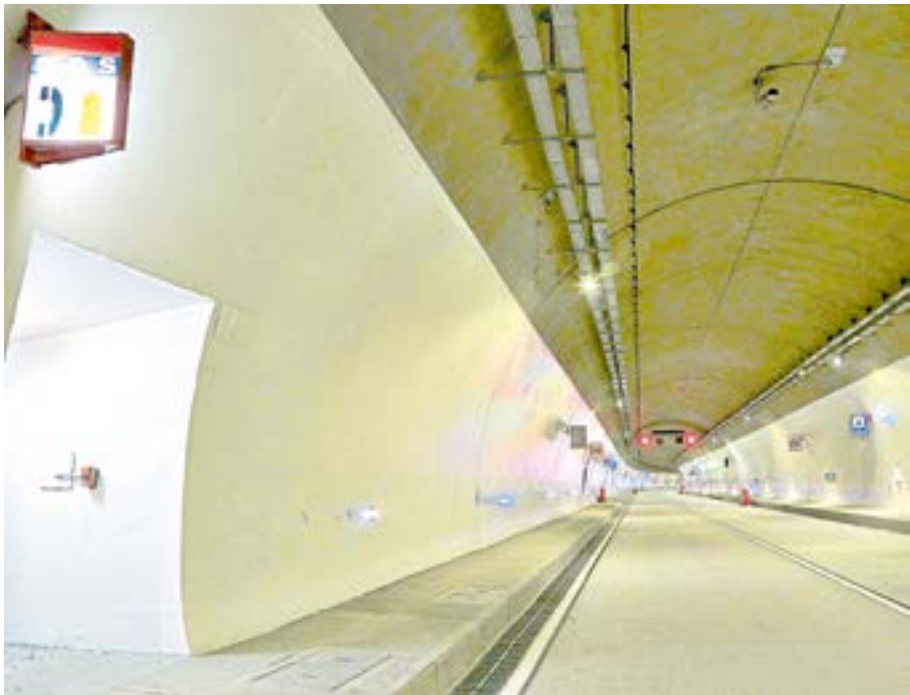
La carretera que de Bogotá conduce a Villavicencio sigue siendo uno de los mayores retos en infraestructura, al ser la vía principal de ingreso y salida de la región.
