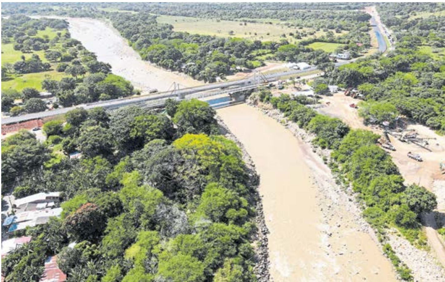
La vía Villavicencio - Yopal es una de las obras de infraestructura importantes para la conectividad del departamento.
