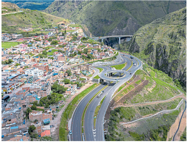
Dentro del proyecto Rumichaca - Pasto sobresalen trabajos como la Glorieta el Pedregal y Puente Gaitara. ANI
