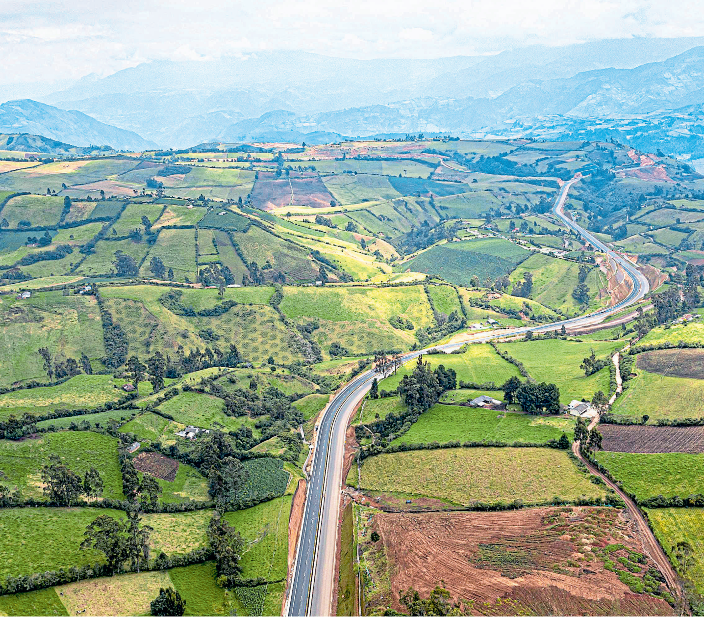
Dentro de los proyectos de infraestructura que más sobresalen en el sur del país está la vía Rumichaca - Pasto, una obra que acerca a esta zona con la frontera con el Ecuador. FOTO: ANI
