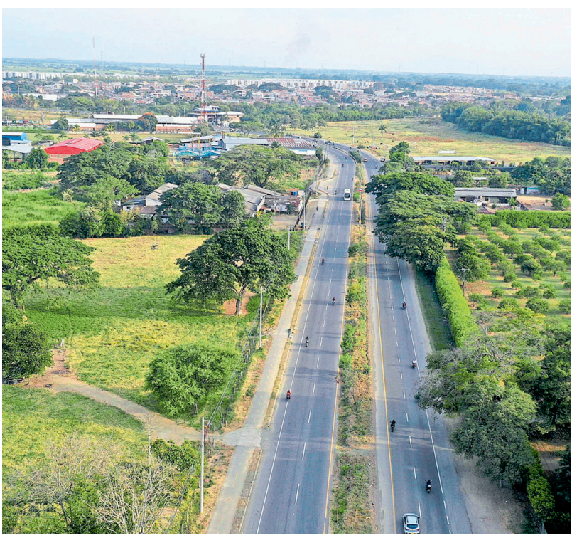
Con proyectos viales como Rumichaca - Pasto (arriba) y la doble calzada Cali-Candelaria Nariño y el Valle le apuestan al progreso. FOTOS: CONCESIONARIA VIAL UNIÓN DEL SUR Y GOBERNACIÓN DEL VALLE.
